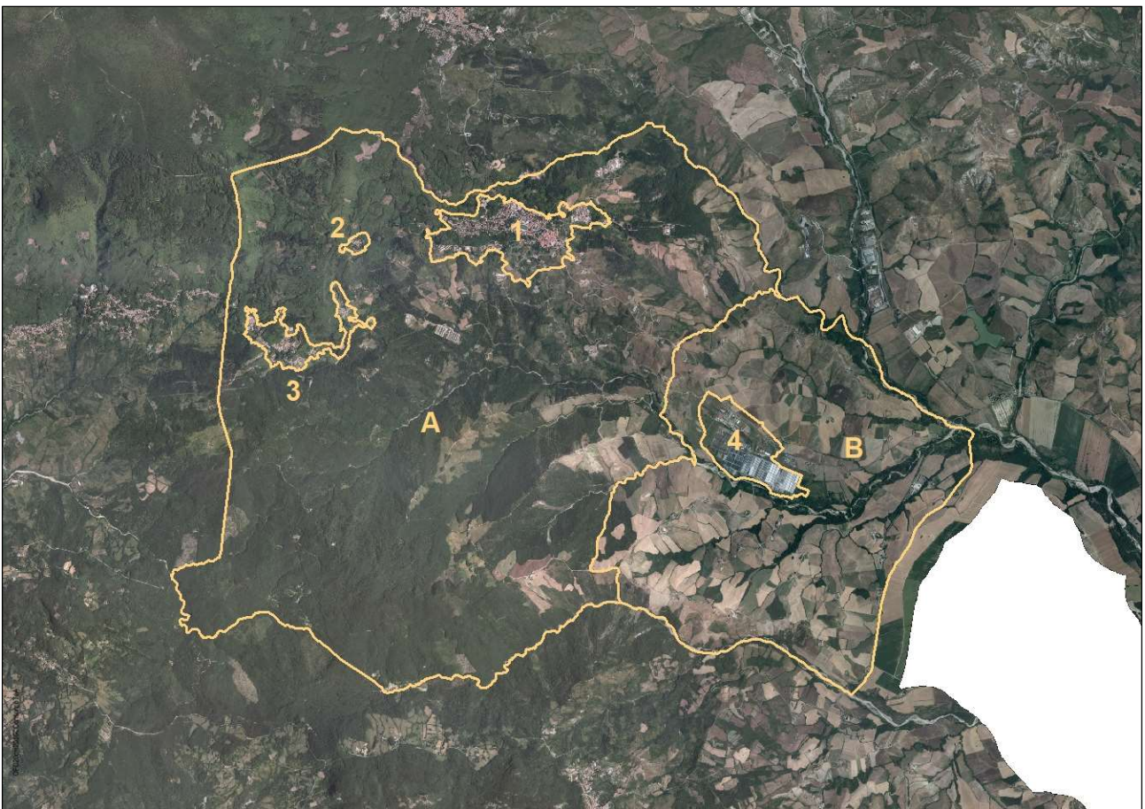
Il territorio del Comune di Piancastagnaio con indicazione delle UTOE (A- Cono dell'Amiata, B - Valle del Paglia) e SUB-UTOE (1 Capoluogo, 2 Quaranta, 3 Saragiolo e Tre Case, 4 Casa del Corto) individuate dal PS. Scala 1:100.000.
