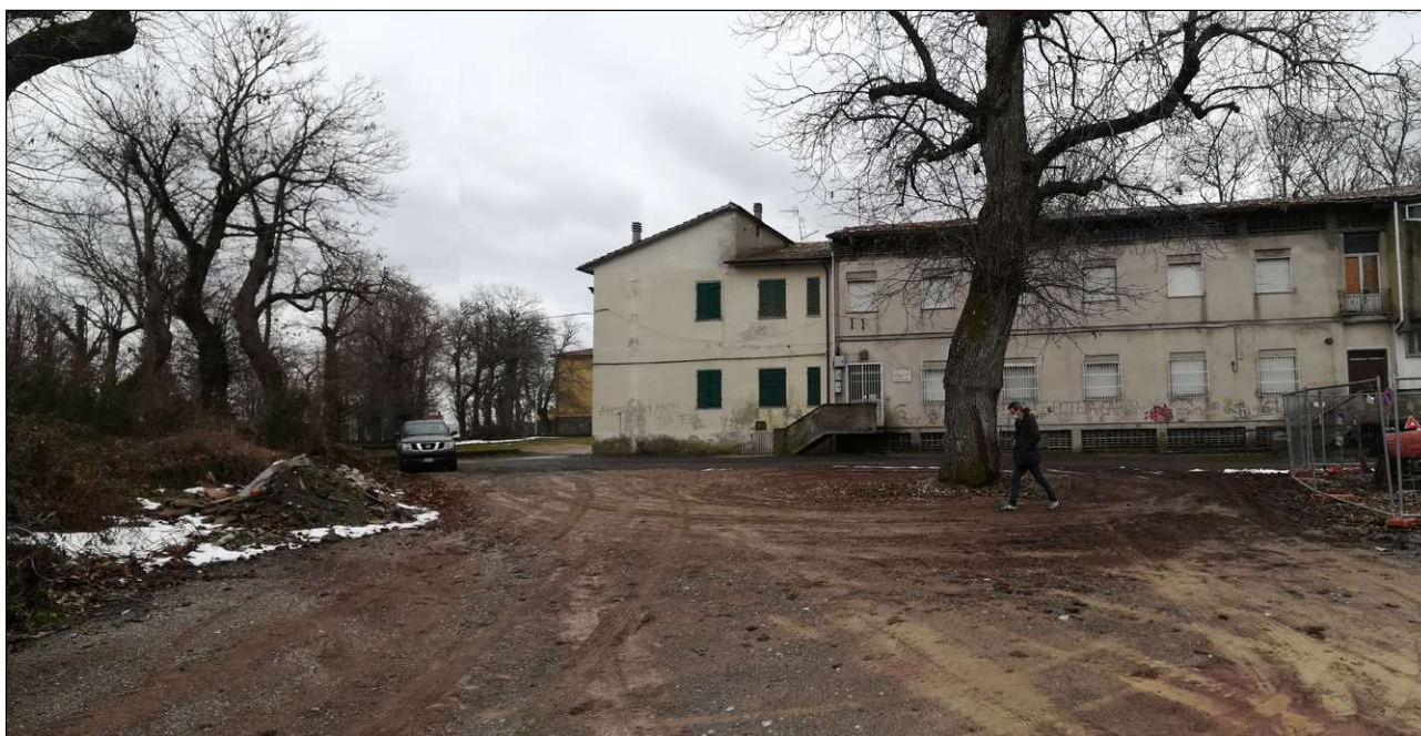
Veduta dal piazzale nord. Sullo sfondo il fabbricato originariamente destinato alla scuola per geometri.
