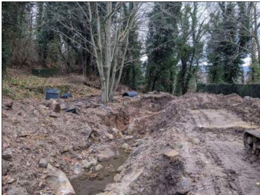
Figura 10: scolo delle acque nella parte centrale dell'area.
